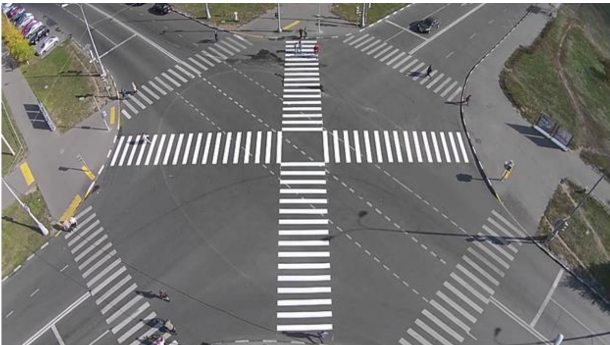
Рисунок 25 – Пример организации диагонального пешеходного перехода с нанесением разметки 1.14.1 или 1.14.2
